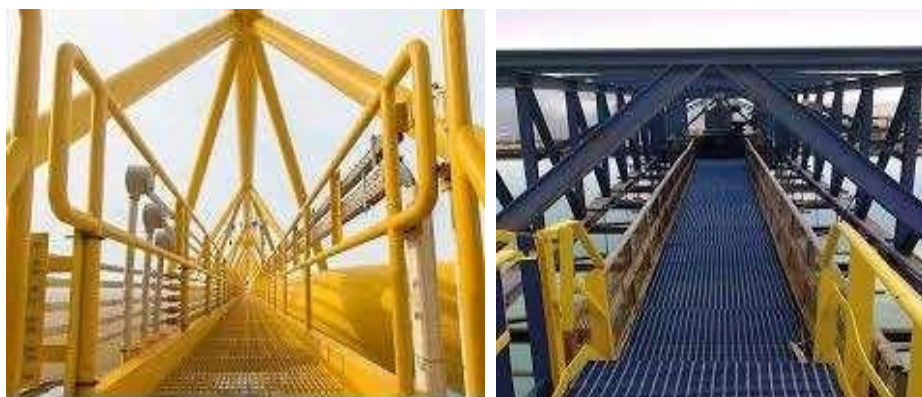
شکل ۲-۲۷ استفاده از پروفیل‌های FRP به عنوان جایگزین پروفیل‌های فولادی، در سازه ها
