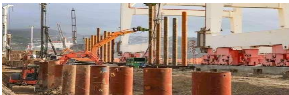
شکل ۲-۵۰ نصب غلاف فولادی ستونهای پل در روش CFT با استفاده از دستگاه شمع کوب
