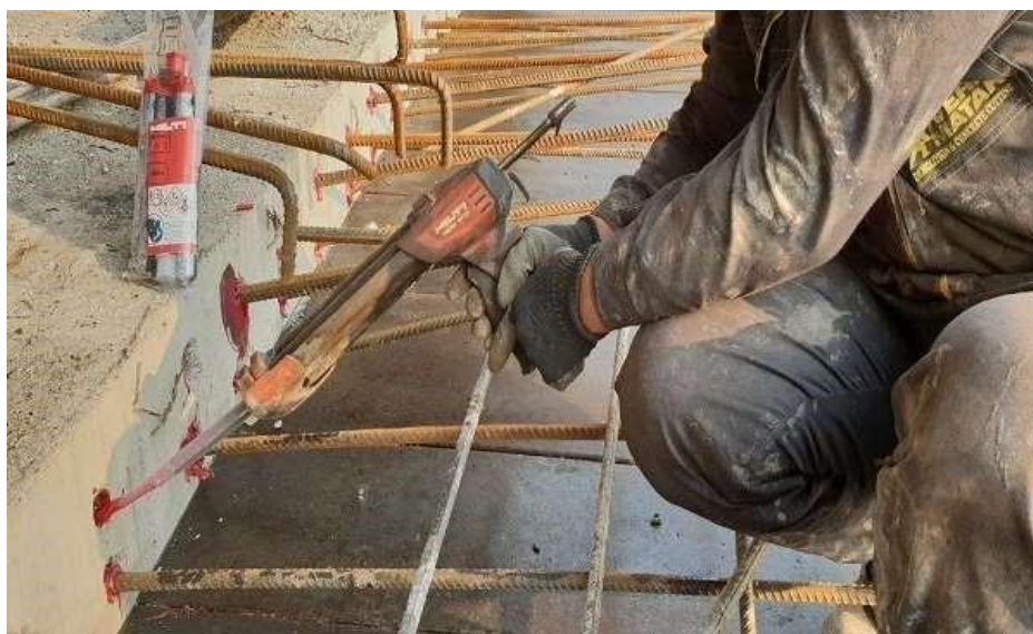
شکل ۲-۳۵ پر کردن سوراخها با چسب مخصوص جهت کاشت آرماتور
