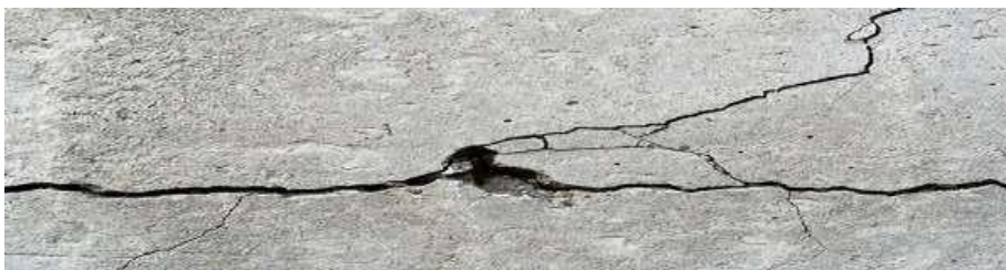
شکل ۲-۴۸ ایجاد شدن ترک در نمونه بتن معمولی، پس از انجام آزمایش ضربه (پس از ۵ ضربه)
