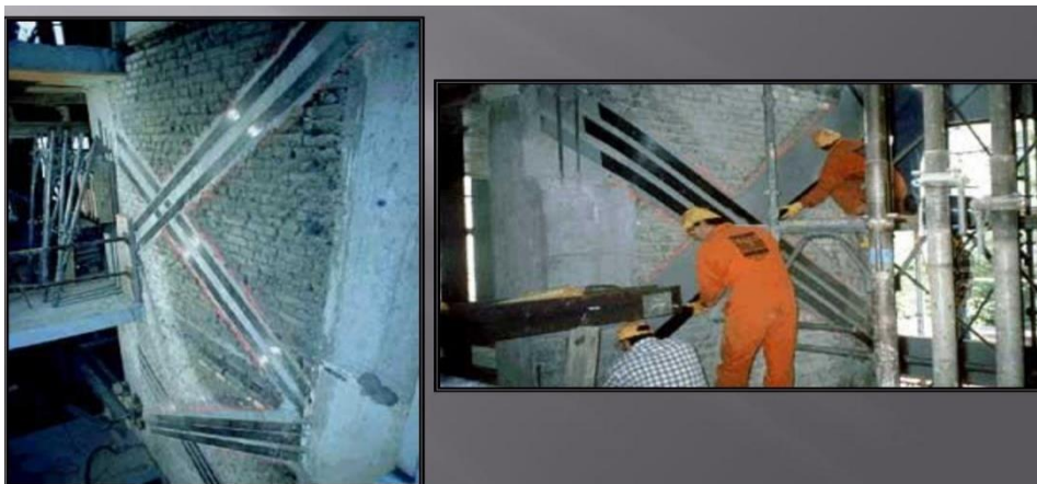
مقاوم سازی دیوار آجری با برسینگ نوار های CFRP
