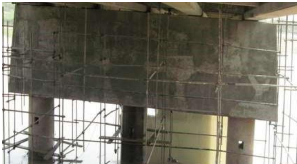
شکل ۲-۵۳ تعبیه دریچه در پایه های پل، به جهت جلوگیری از آب شستگی در هنگام جزر و
