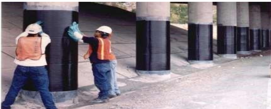
شکل ۲-۲۲ چسباندن پارچه های FRP به سطح بتن
