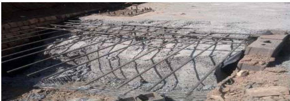
شکل ۲-۴۰ محل ایجاد بند ساخت (درز اجرایی) در هنگام بتن ریزی
