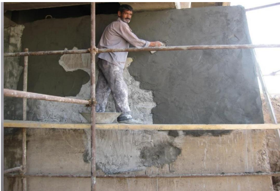
(شکل ۳-۱) ترمیم سطوح آسیب دیده با مواد مخصوص تعمیر
