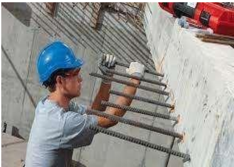
شکل ۲-۳۶ اضافه کردن آرماتور و چسباندن آن
