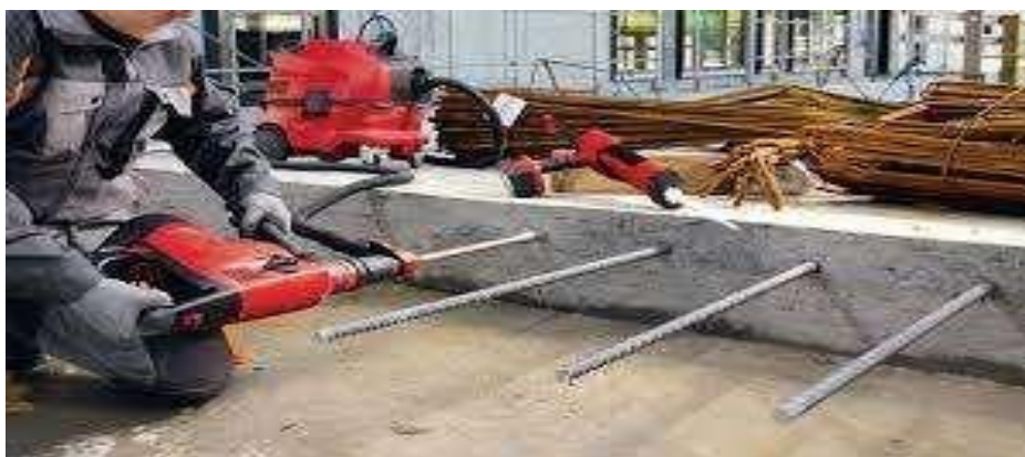
شکل ۲-۳۴ عملیات سوراخ کاری جهت کاشت آرماتور
