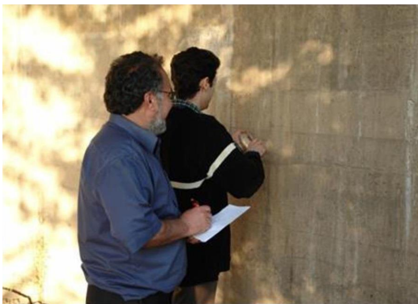
تست و اجرای چکش اشمیت
