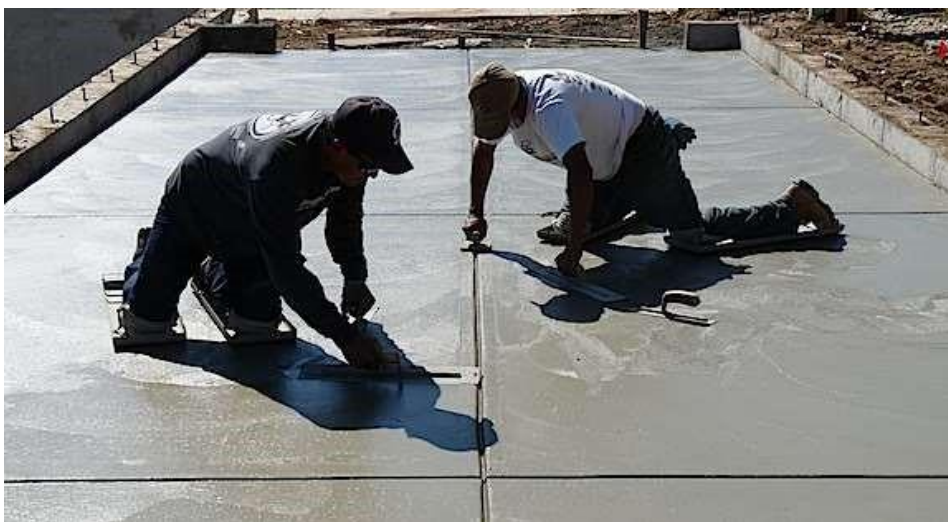
شکل ۲-۳۹ نسبت طول به عرض چشمه های بند کنترلی، ۵.۱ به ۱ میباید
