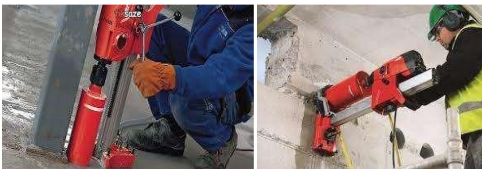
(شکل ۱-۲) ایجاد حفره در بتن به وسیله دستگاه مخصوص کرگیری
