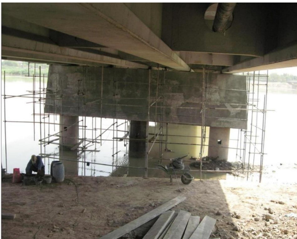
(شکل ۴-۱) پایه پل سوم بعد از تعمیر
