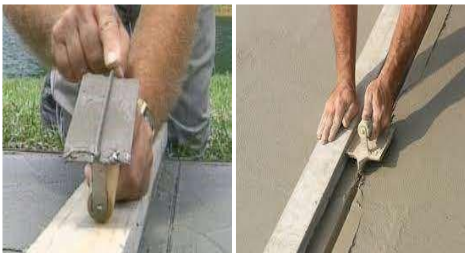
شکل ۲-۳۸ بند کنترلی و نحوه اجرای آن
