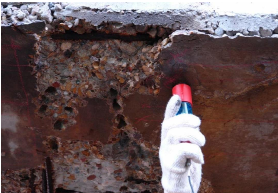
بررسی میزان خوردگی با کانین تیر بتنی پل
