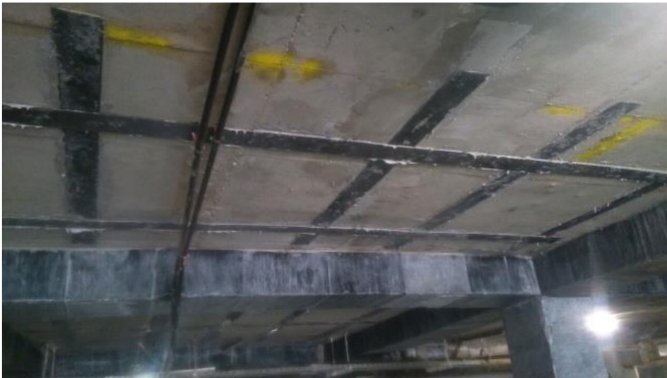
شکل ۳-۱۰ مقاومسازی سقف و تیر و ستون بیمارستان با سیستم CFRP
